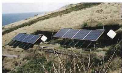
◀ソーラーパネル 機材の電力は太陽光発電でまかなっている
