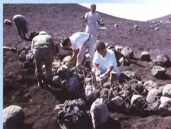
砂防工事 (1997年6月頂上部で蛇籠の設置)
